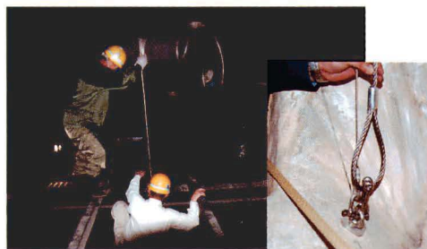
図3 キャットウォークでワイヤの調節・固定作業を行う篤の皆さん（左）と標本側吊具（右）。右の写真で右側の太いのが直径9mmの新しいワイヤ、左側の細いのが直径4mmの古いワイヤ。
