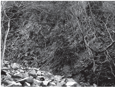
図5 山の斜面に露出する柱状節理の崖。早川の水面から10mくらい上ったところにあるこの崖がある。足元には落ちてきた柱状節理の破片が転がり、不安定で危険。
