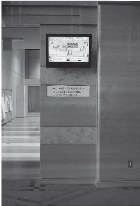
発電量モニターは、エントランスホールにも設置された。
