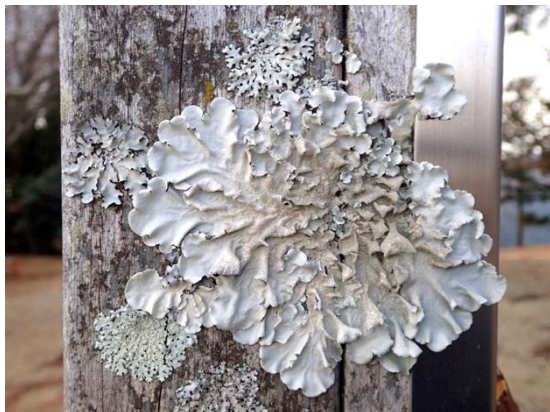
図1：看板の木枠の側面に生えた多数の地衣類。
