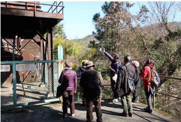
山崎発電所導水管の頂上を見る
