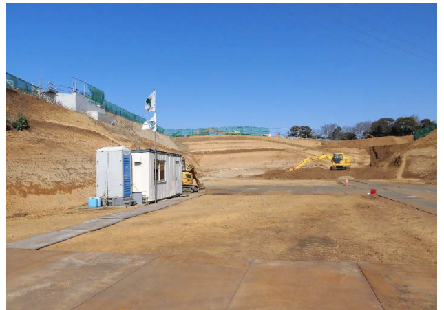
北露頭西・北・東面に広がる工事中の大露頭
