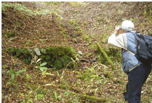
石張排水溝と土留めの石積み
