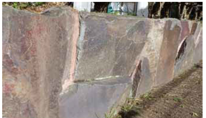
図3. 根府川石と思われる板状節理の安山岩を使った石垣
