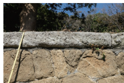
図3. 旧吉田茂邸に見られる石垣。上部がシンドーサキ石、下部が高麗石。
