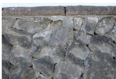
図2. 大磯のシンドーサキ石を用いた石垣。
