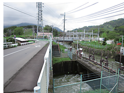
図2 内山発電所。背後の段丘との落差を利用して発電。手前の取水が文命用水となる。
