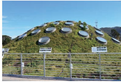
図8 図7の右上口部分の拡大。丸窓は館内の熱帯雨林スフィア（球体）の採光部になっている。
