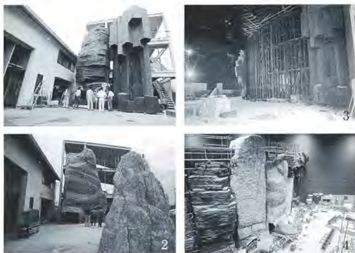
図2.岩石壁を組み上げる様子。
