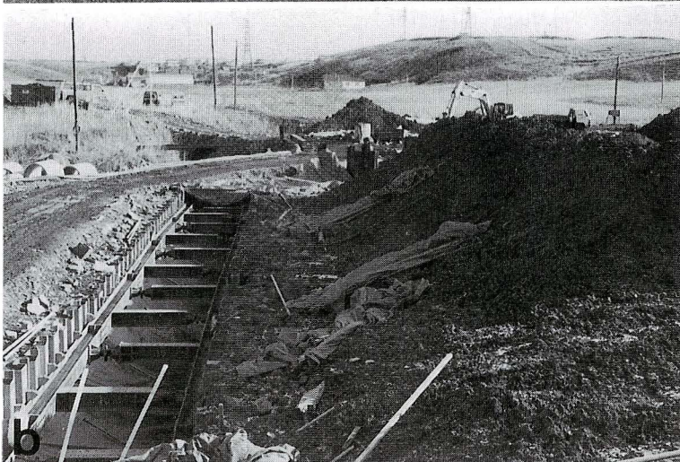
図 3b. ハッターリ川低地の下水道工事現場 (ハッターリ川左岸)。
