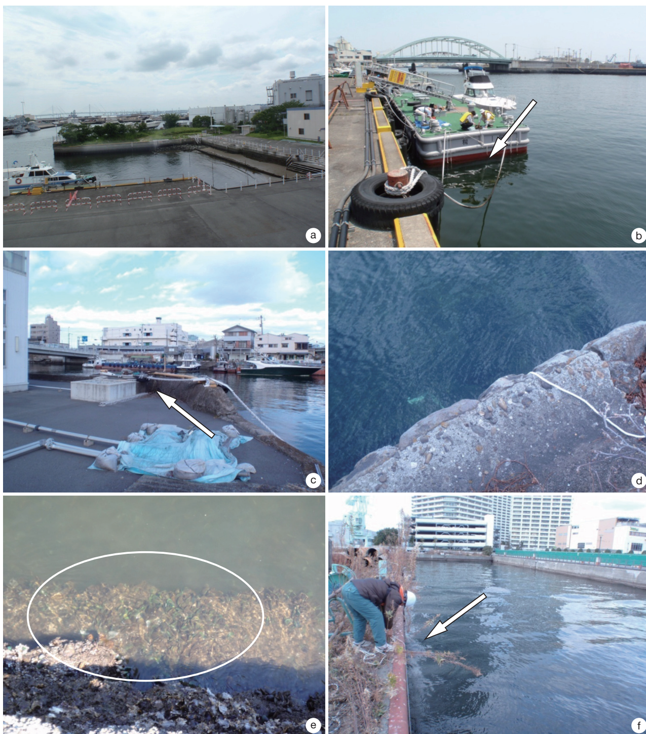
図2. 調査地点周辺の状況とミドリイガイ付着現場。a: St. 1 の周辺全景; b: St. 1 の温度計・生簀籠垂下位置 (矢印の部位); c: St. 2 の温度計垂下位置 (矢印の部位); d: 垂下開始時の St. 2 の付着現場 (2011 年 1 月 6 日); e: 温度計回収時の付着現場 (2011 年 4 月 19 日); f: St. 3 の温度計垂下位置 (矢印の部位)。
