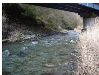
St. 28 湯ノ沢橋
