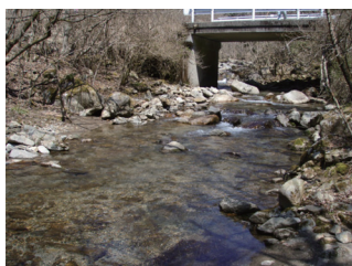
St. 18 白水沢・白水沢橋
