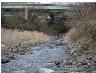
St. 23 新樋口橋
