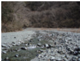
St. 14 小菅沢橋
