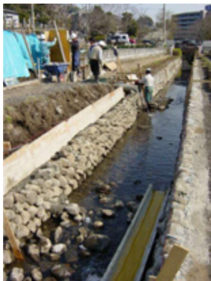
図 2. 用水路の改修工事.
