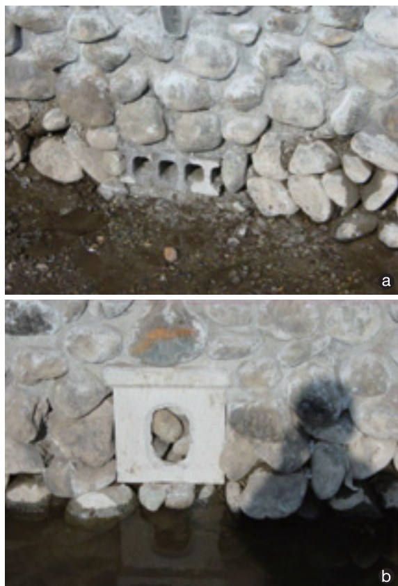
図 3. a: 隠れ家として埋め込まれたブロック; b: 隠れ家として埋め込まれた石が充填された排水升.
