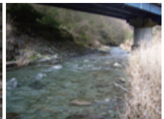
St. 28 湯ノ沢橋
