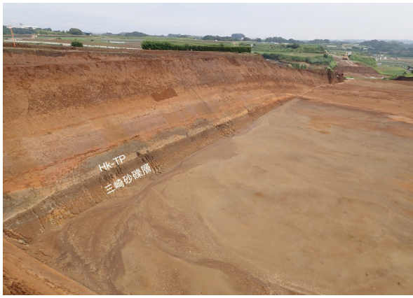
図 18. 三崎面とその断面. 三浦縦貫道工事現場 (三浦市初声) (撮影者: 笠間友博).
