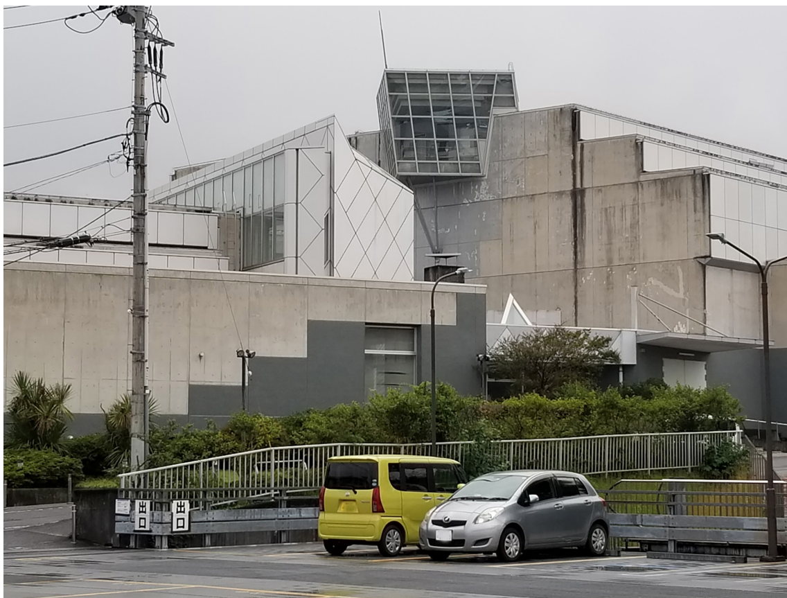
図 2. コウモリのコロニーが見つかったコンクリート建築物.
