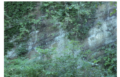
図8. 観音崎の採石場跡。地層が右上から左下に傾くのに対し、ノミの痕が急角度で左上から右下に向かって無数に見られる。
