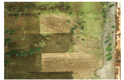
図7. 観音崎の砲台の石垣。右側の白っぽい石材が房州石で、左側の茶色い石材がおそらくは地元産の池子層の凝灰岩。
