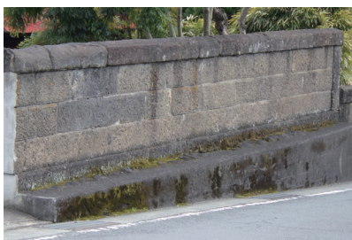
図5. 湯河原町鍛冶屋のかま石で造られた石垣。
