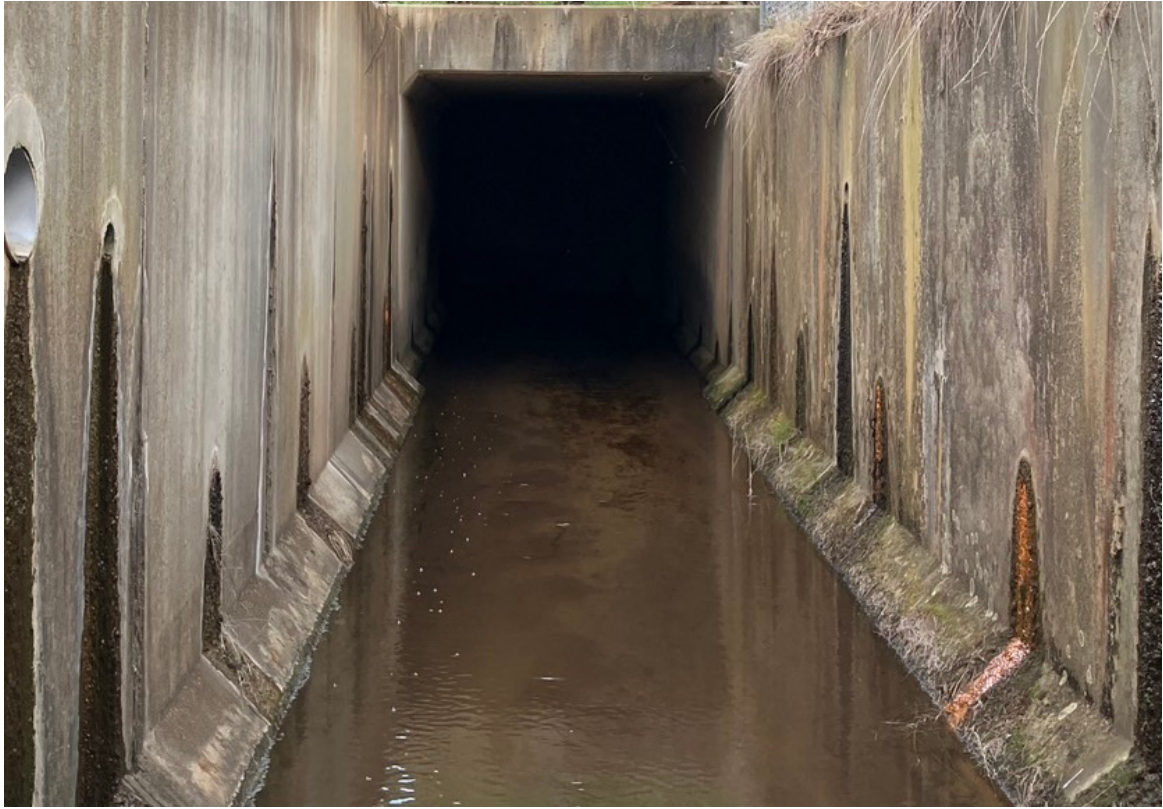
図 4. モモジロコウモリ及び、ユビナガコウモリが確認されたボックスカルバートの外観.
