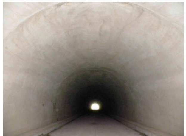
図 1. モモジロコウモリの出産哺育コロニーが見つかった隧道の内部。
