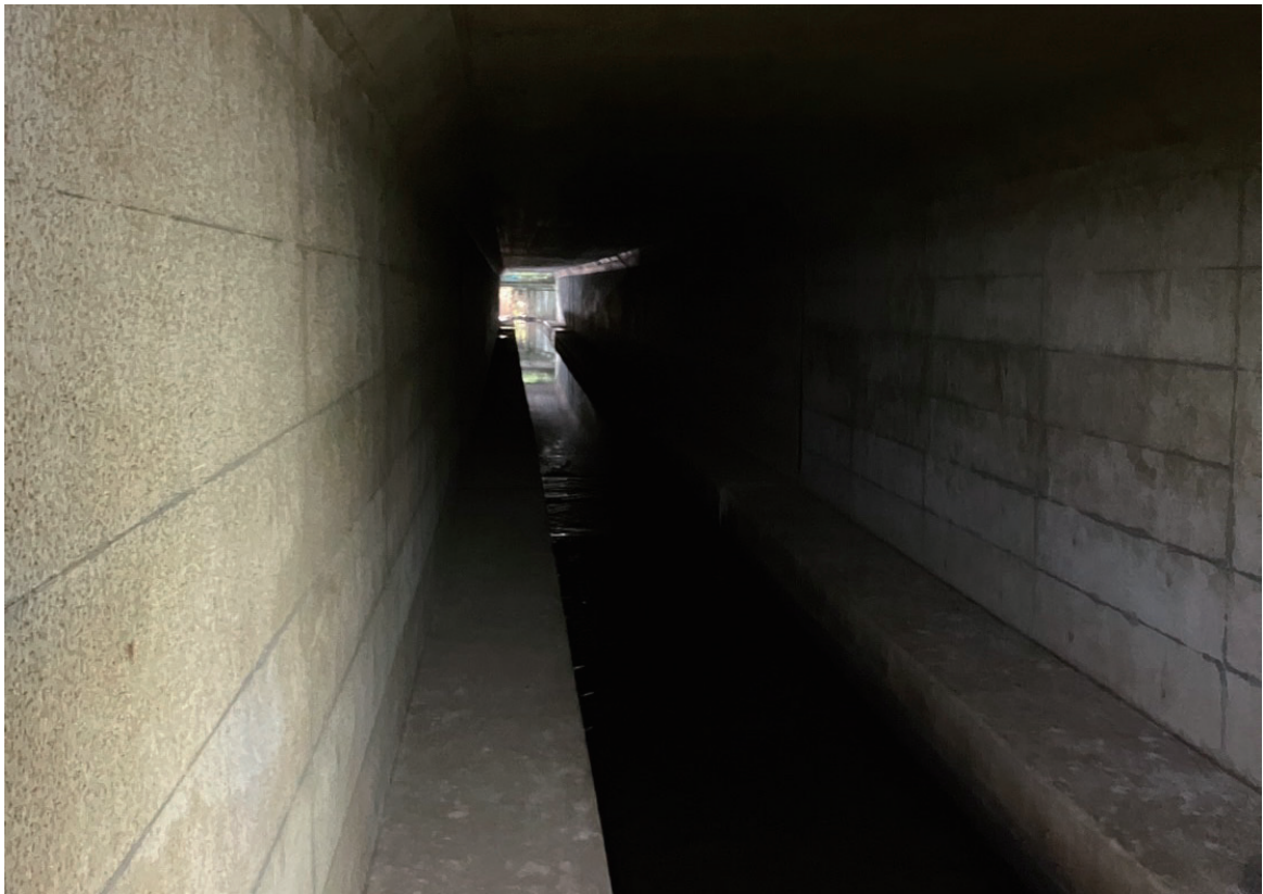
図 5. モモジロコウモリが確認されたボックスカルバートの内部.
