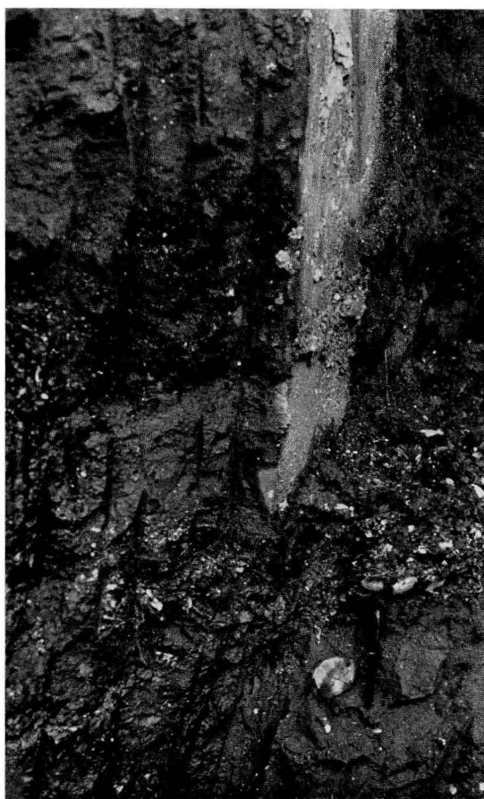
3. K-6L 試料採集地点：若宮大路ガード際 鎌倉ポンプ場海拔-2.0～-3.0m
