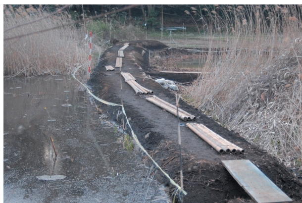
図 5. 工事区に出現した堰堤のような“畦”
