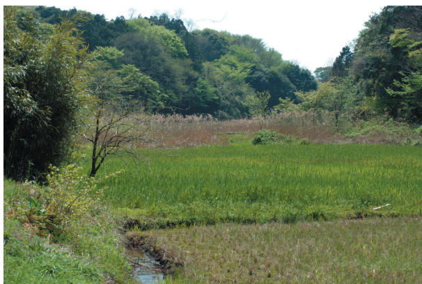
図 1. 谷戸低地の工事が行われる前の柳谷 (2005.04.19 撮影)
