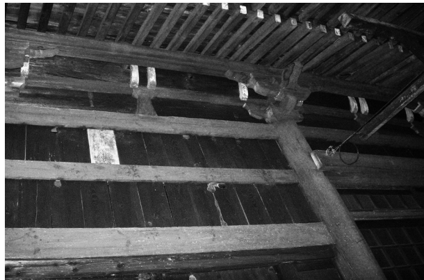
図 7. ヒナコウモリが出入りしていた日向薬師の壁面。
