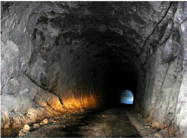
図 2. 手掘りの青崩隧道の内部（下流側）
