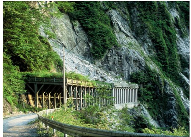
図 3. 青崩隧道の上流側の洞門
