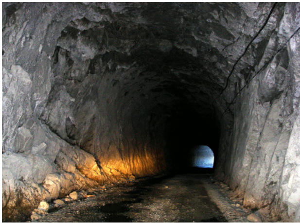
図 2. 手掘りの青崩隧道の内部（下流側）
