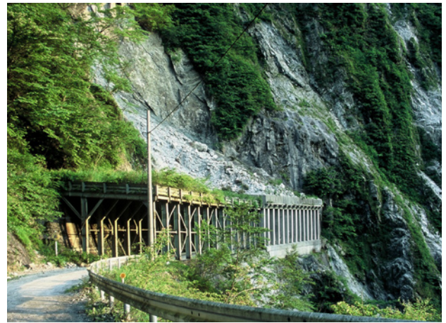
図 3. 青崩隧道の上流側の洞門
