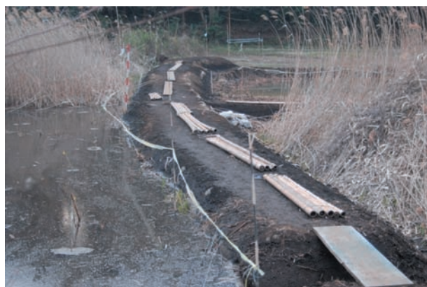
図 5. 工事区に出現した堰堤のような“畦”
