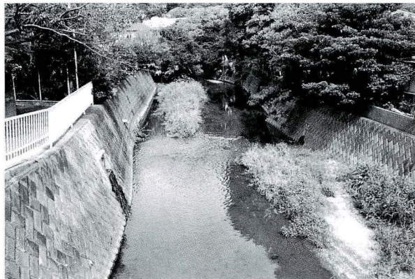
図3. 亀井戸橋付近の状況。
