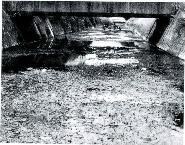
図 3. 両岸がコンクリートで固められた人工護岸 (E 地域).
