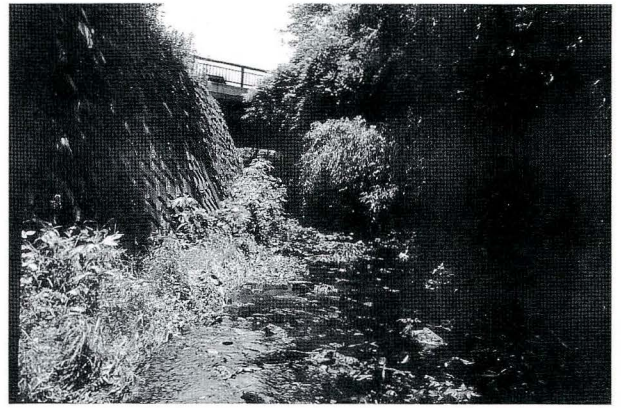
図3. St.B M橋の状況.
