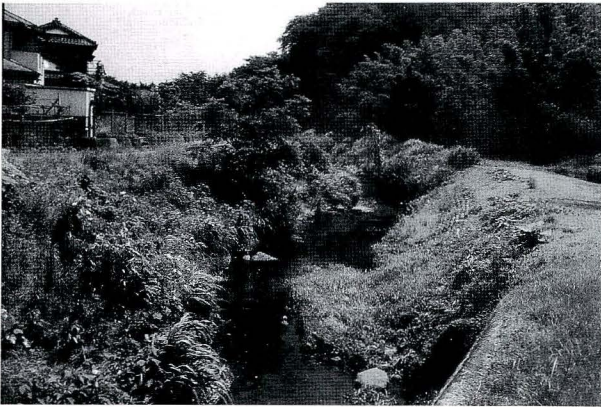
図6. St.E わき橋の状況.
