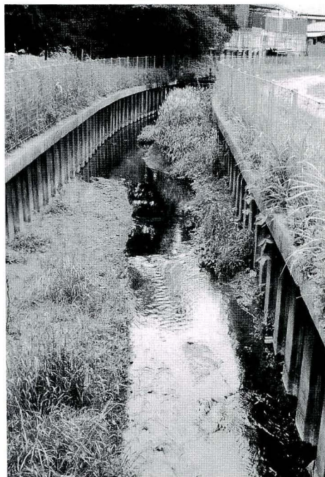
図12. St.K 滝沢境橋の状況.
