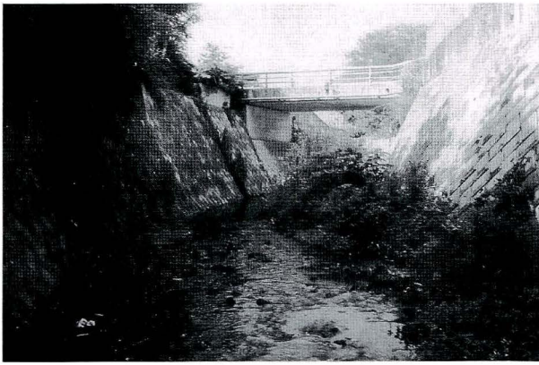
図2. St.A 中入橋の状況.
