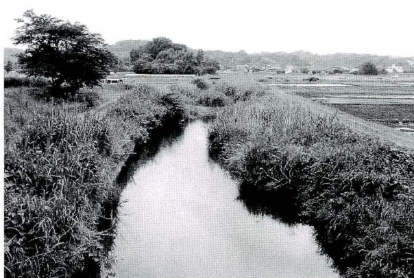
図9. St.H 佐の橋の状況.
