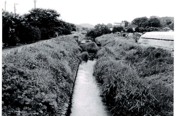
図7. St.F 基打橋の状況.
