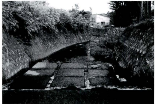
図8. St.13: 竜良川・竜良川橋
