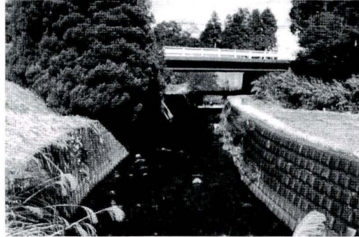
図7. St.11: 前川・前川橋
