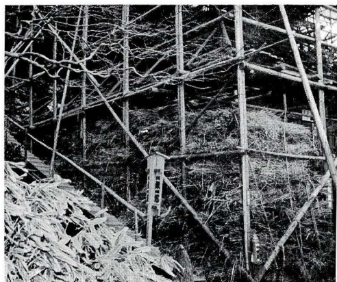
図2 本堂かやぶき屋根の改修現場。 屋根材にはススキとアズマネザサが使わ れている。(1980.1.20)
