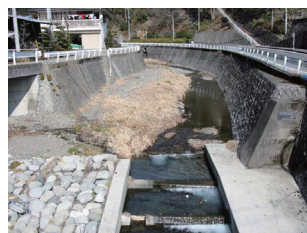
St. 6 上沢井橋
