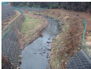
St. 37 新一の沢橋
