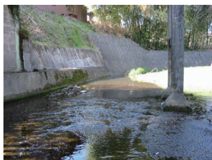
St. 30 荻野川・新道橋
