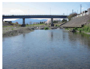
St. 28 第2 鮎津橋
