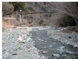
St. 24 本谷川・本谷橋
