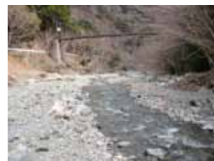
St. 24 本谷川・本谷橋
