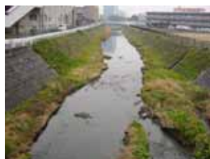
St. 35 恩曾川・長ヶ町橋
