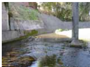
St. 30 荻野川・新道橋
