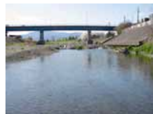
St. 28 第2鮎津橋
