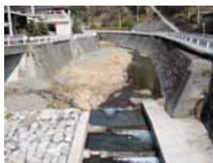
St. 6 上沢井橋
