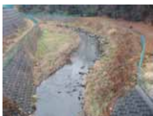
St. 37 新一の沢橋
