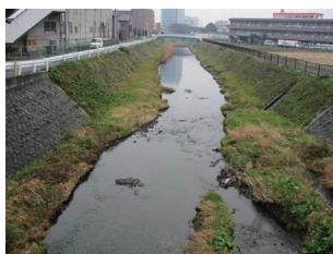
St. 35 恩曾川・長ヶ町橋
