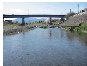
St. 28 第2鮎津橋
