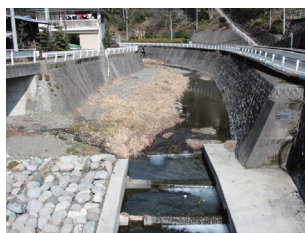
St. 6 上沢井橋
