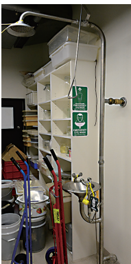
図5 オーストラリア博物館の液浸作業室に備え付けられた非常用シャワーと洗面台。
