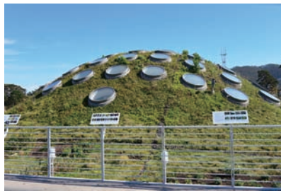
図8 図7の右上口部分の拡大。丸窓は館内の熱帯雨林スフィア(球体)の採光部になっている。
