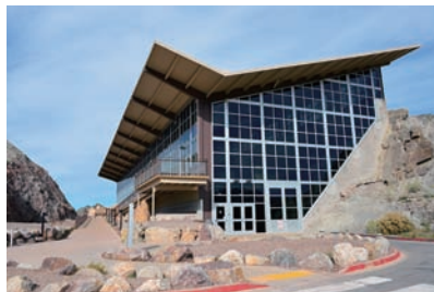
図3 展示館。ボーンベッドの露頭に建物がかぶせてある。
