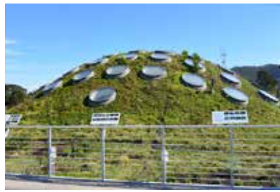
図8 図7の右上口部分の拡大。丸窓は館内の熱帯雨林スフィア(球体)の採光部になっている。
